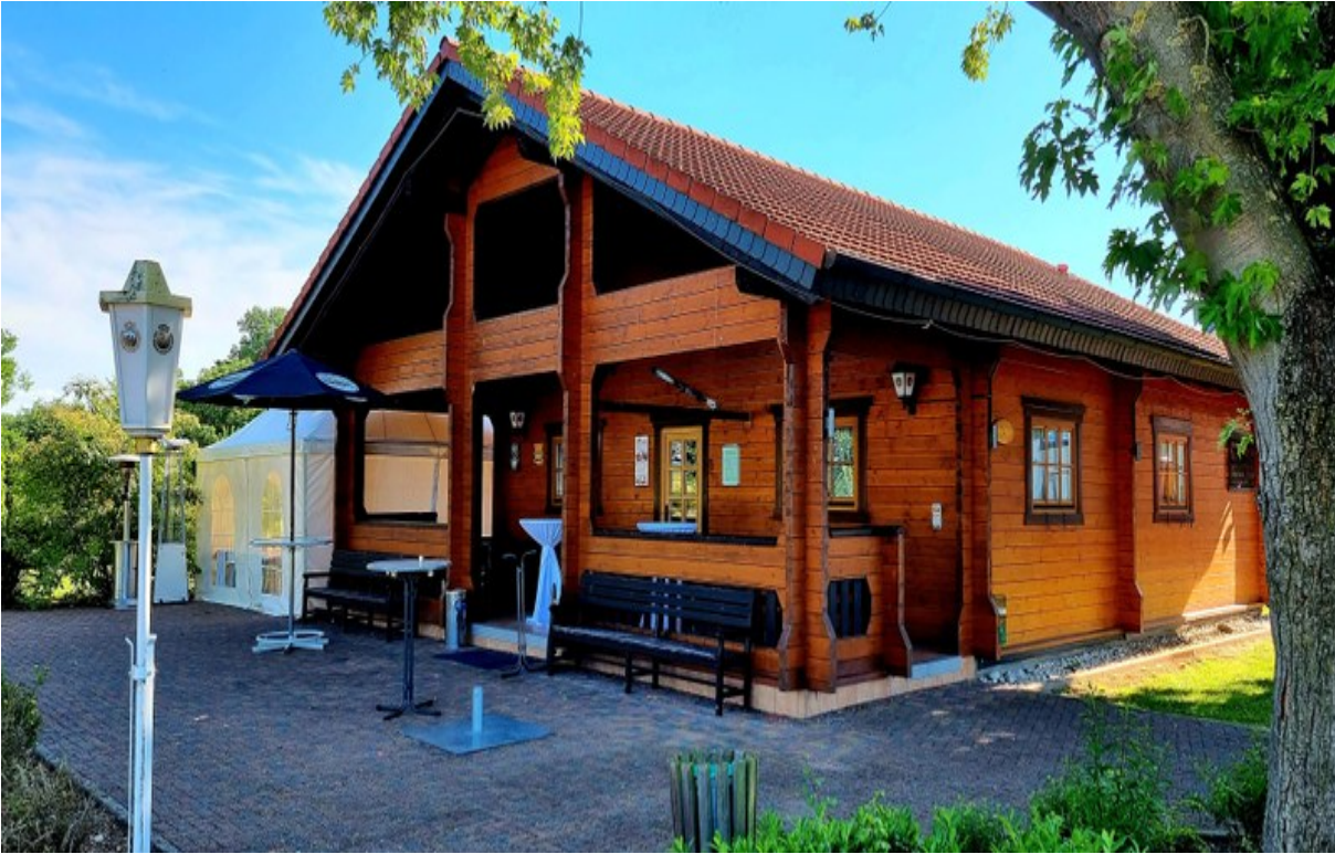
Blockhaus des Landgasthof Hotel Bechtel
